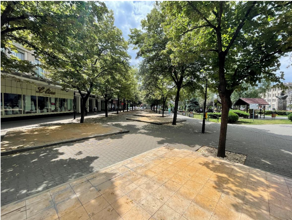
Figură 2-30 Disfuncționalități - Parcul Nechita Stănescu – zona pietonală obturată de foste fundații ale unor construcții temporare
